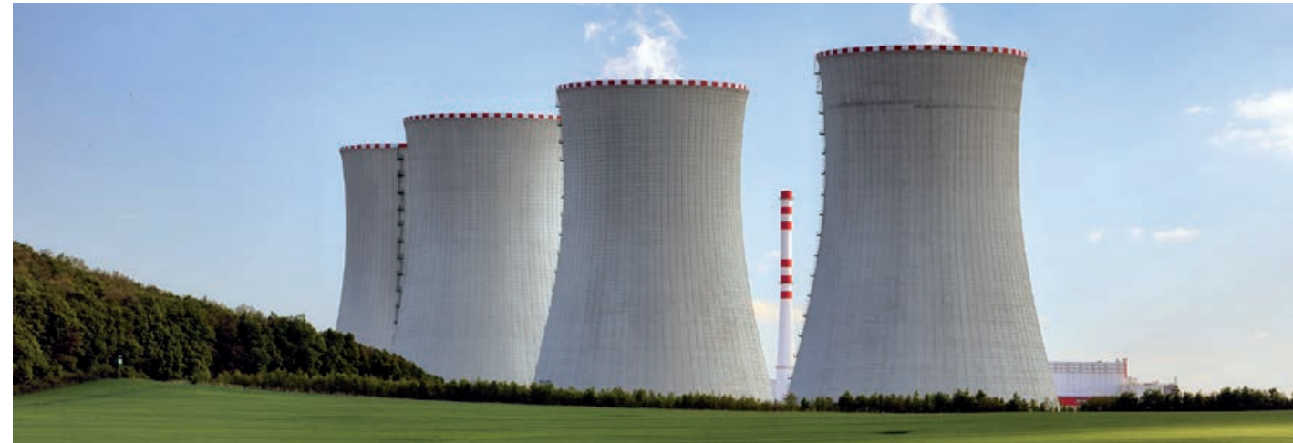
Pyroalliance sécurise des centrales nucléaires
